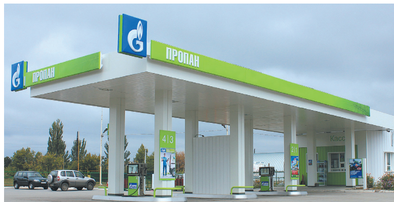
АГЗС Группы компаний ОАО «Газпром газэнергосеть», расположенная по адресу: Волгоградская область, г. Волжский, ул. Горького, 41В.
