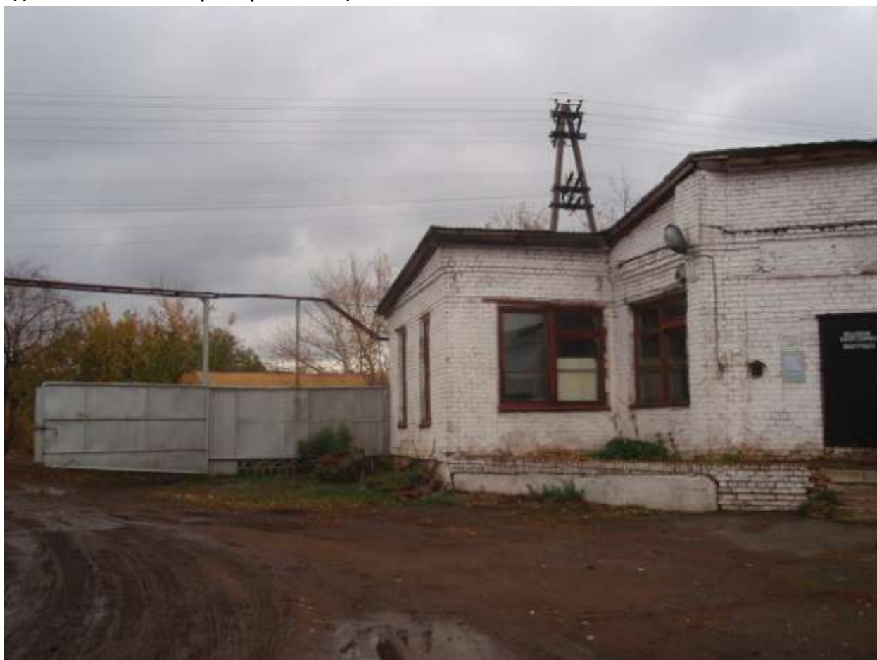
Здание насосно-компрессорной станции
